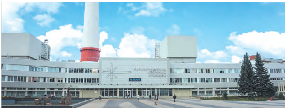
Ленинградская атомная электростанция. За её строительство И.И. Семькин был удостоен звания лауреата премии Совета министров СССР.
