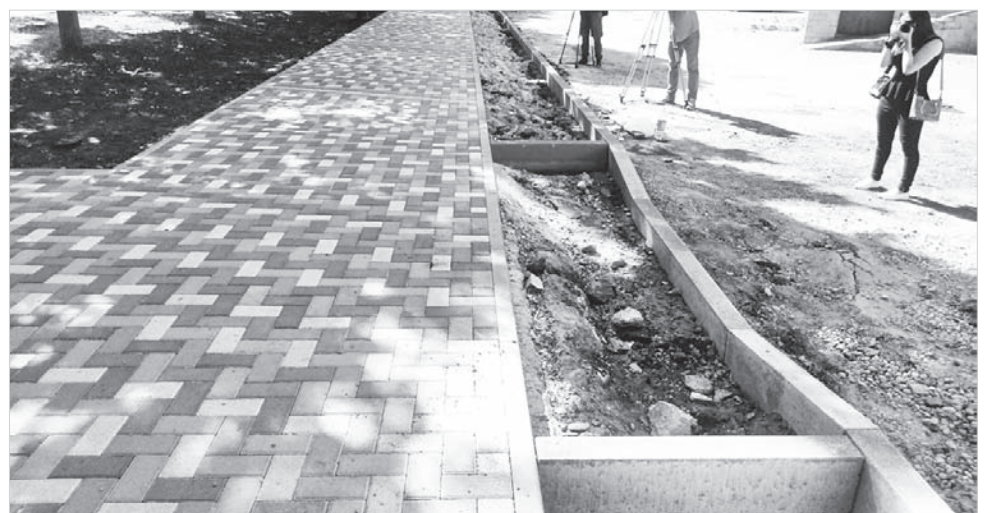
На бульваре вдоль улицы Васильева осталось устроить плавные съезды с тротуара.
