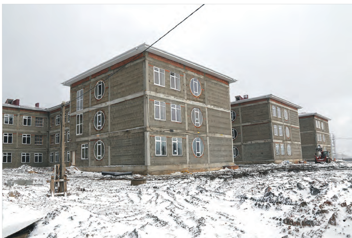
Школа в 530-м квартале: здание почти готово.
