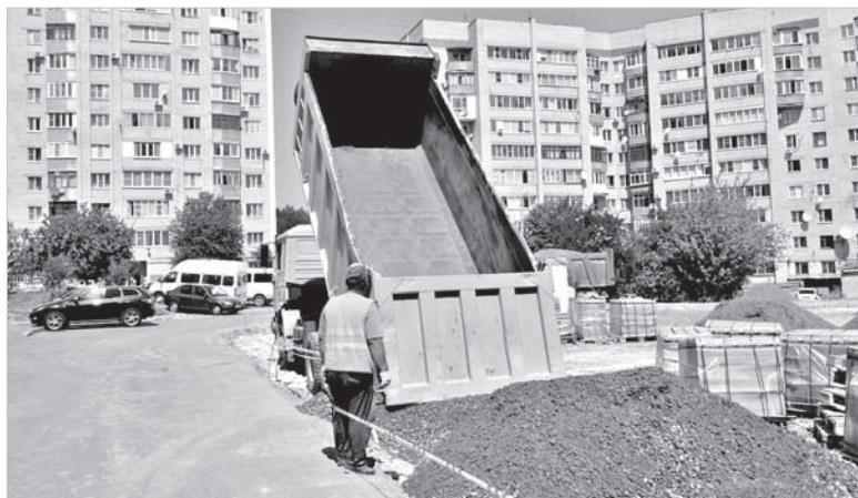
Идет отсыпка будущей парковки.
