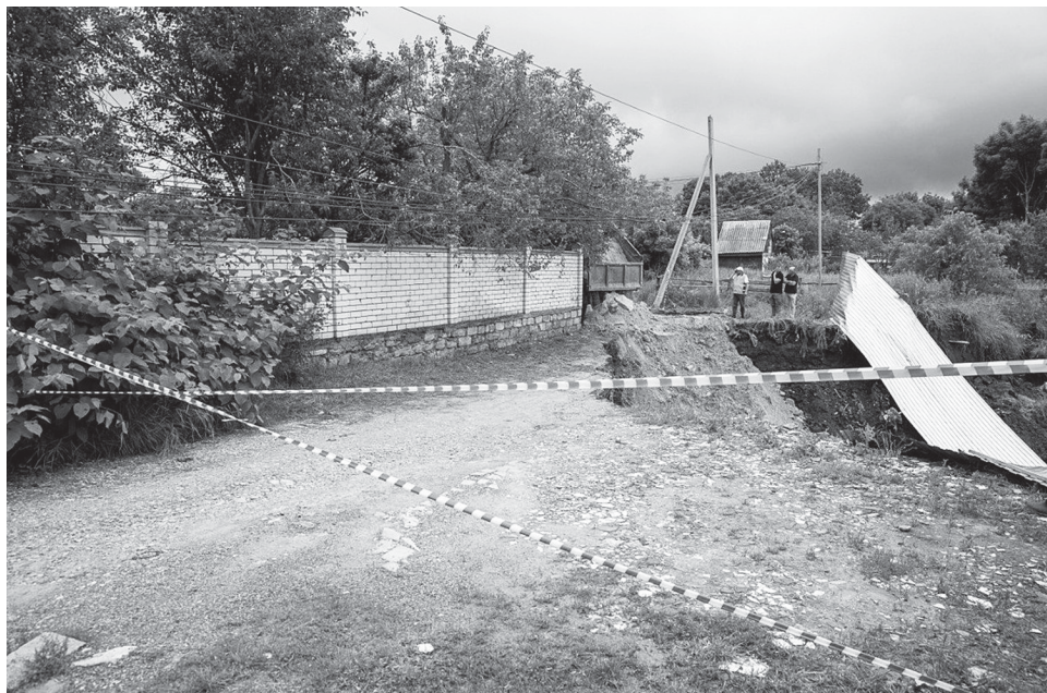
В тупике Монастырском начали ремонт дороги и коллектора
