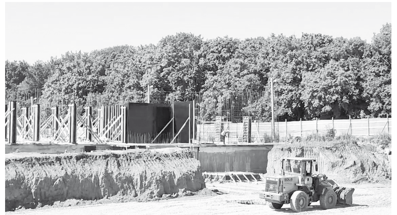
Строительство школы на улице Чапаева краевого центра
